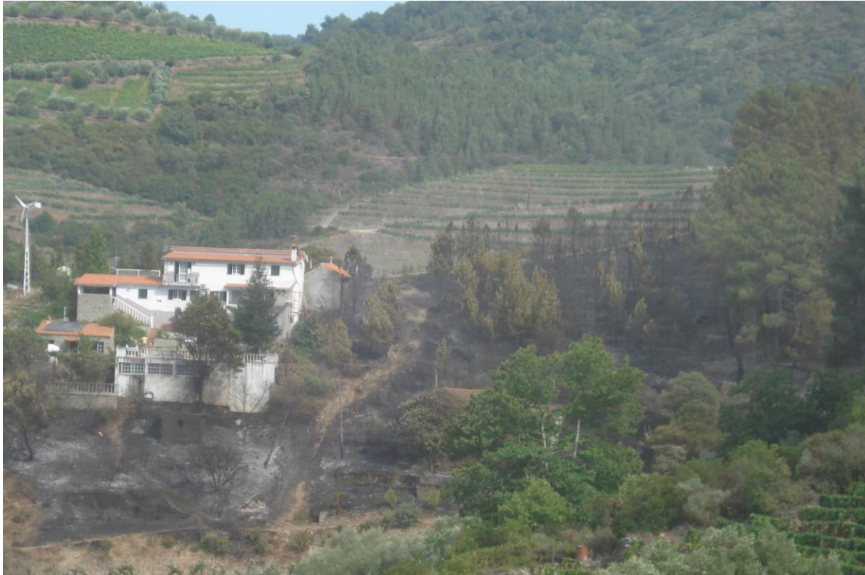
Abbildung 7: Vegetationsbrand hat ein Gebäude passiert. Achten Sie bei der Kontrolle Ihres Grundstückes auf umstürzende Bäume!
